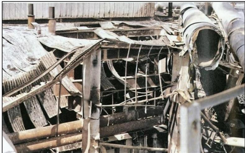
Abbildung 30: Die ausgebrannte MVA Spittelau
