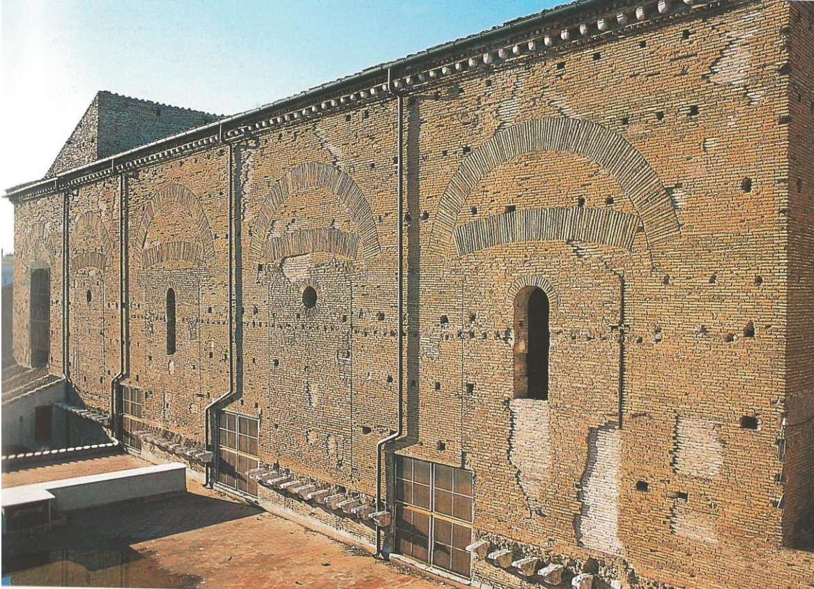
Abb. 47: S. Croce in Gerusalemme; Die kaiserliche Halle mit den großen Fenstern des Obergadens. Sie wurden im Mittelalter zugemauert.
