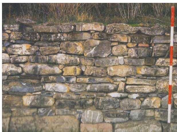
Abb.23: Insula A.I: Mauerstruktur aus unregelmäßigen Flyschsteinen
