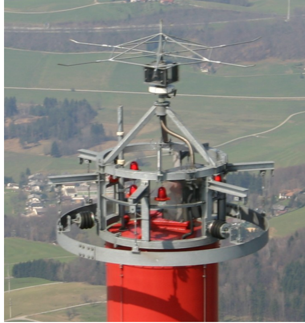
Abbildung 3.3: Mastspitze des Senders am Gaisberg mit Blitzfangstangen und darunterliegendem Messwiderstand (Diendorfer et al, 2011)
