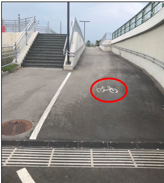
Foto 3: Zugang Watschingersteg aus Richtung der Hauptstraße Quelle: eigene Aufnahmen 31.08.2018
