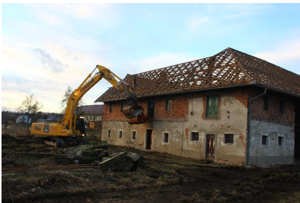
Bild 4: Abriss eines Gehöfts in der Absiedlungszone, Rodl, Walding. © Verfasser, 2018.
