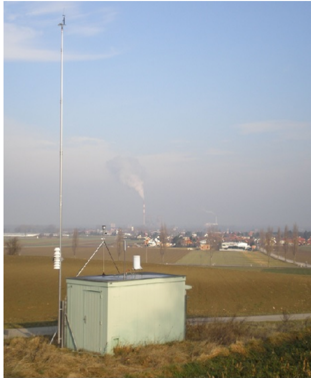
Abbildung 3.6: Messstation: Streithofen im Tullnerfeld - Blickrichtung nach Norden 6
