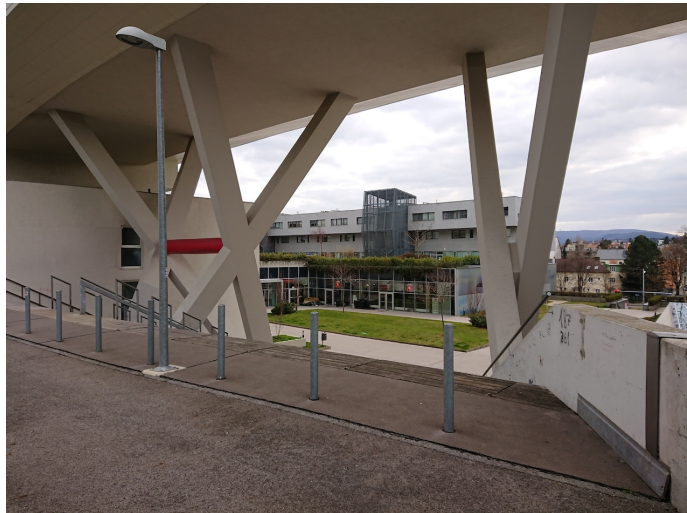
Foto 5: Innenhofanlage des Wohnbaus auf dem ehemaligen Brauereigelände
