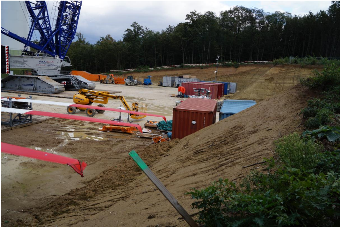
Abb. 2: Kranstellfläche mit Böschungsflächen (eigene Aufnahme 2020)
