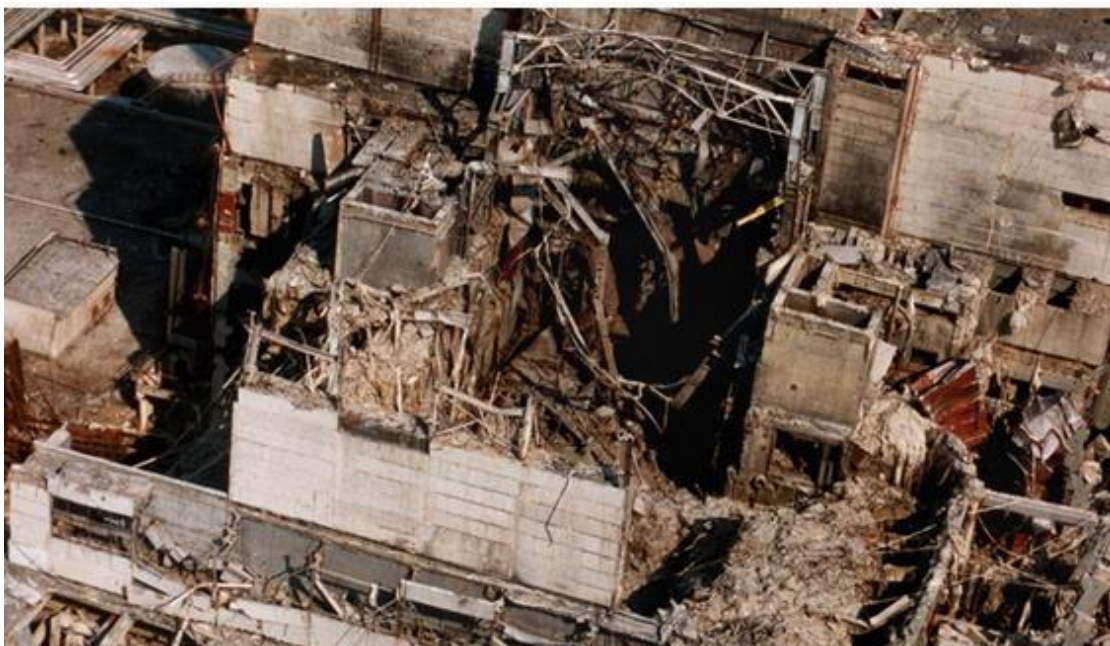
Abbildung 13: Zerstörter Reaktor Block 4 von Tschernobyl
