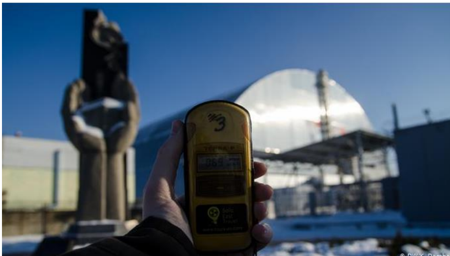
Abbildung 23: Reaktorblock 4 mit der neuen Schutzhülle
