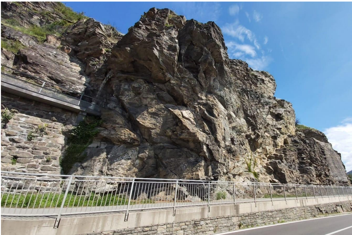
Abbildung 132a Standort der möglichen Keilbewegungen am Westportal des St.Michael Tunnels.
