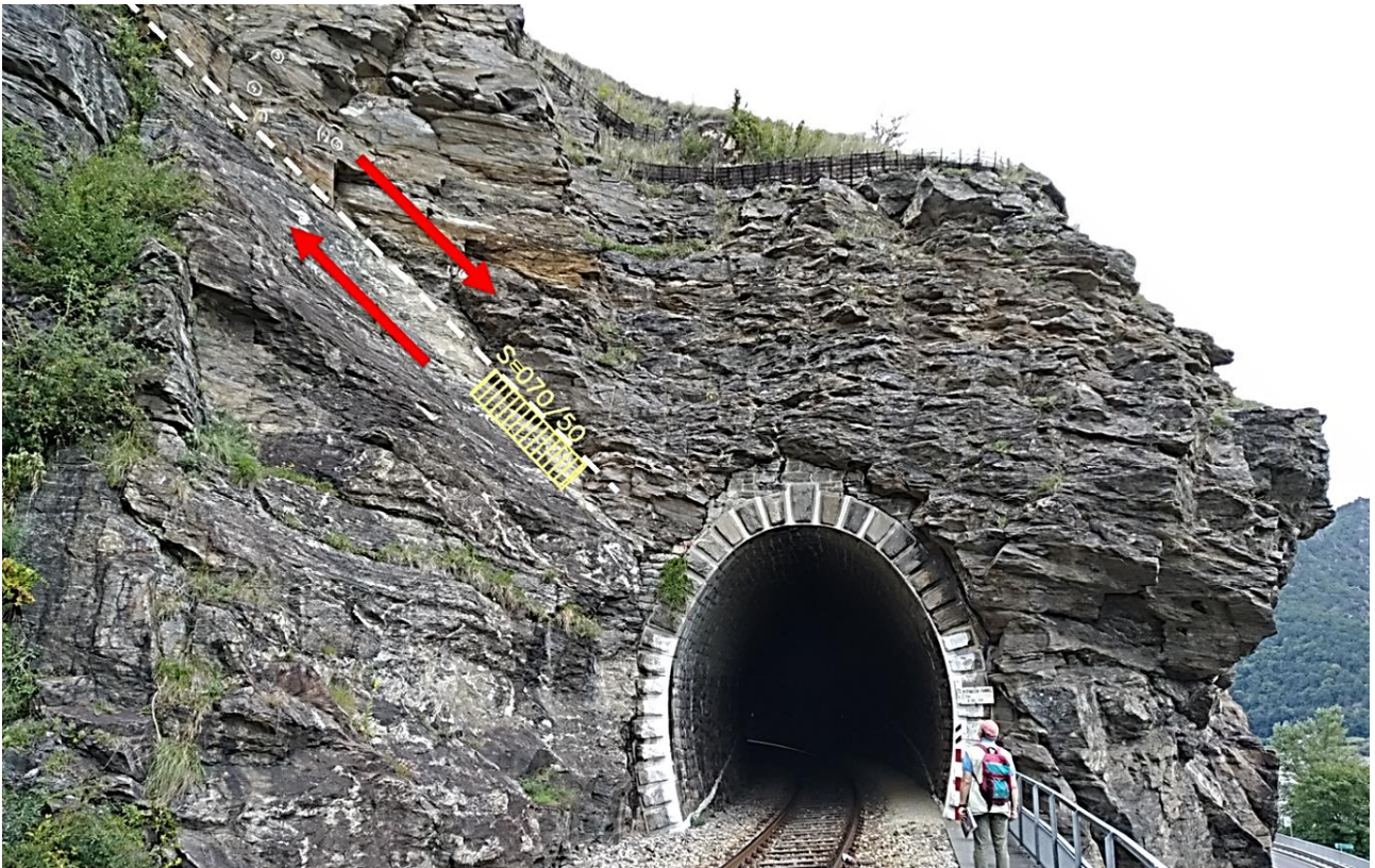
Abbildung 18: Ansicht Westportal, die Abschiebung links des Tunnels und die Innenschale des Tunnels (Mischmauerwerk) sind beobachtbar.
