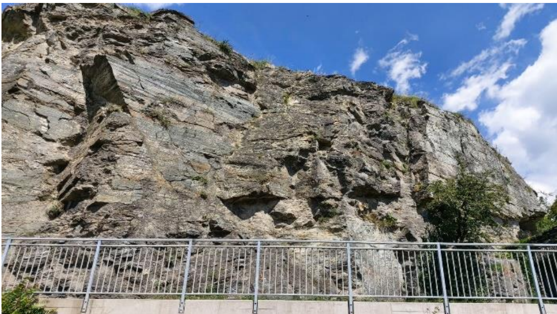
Abbildung 133b Standort der möglichen Keilbewegungen in den Portalböschungen des St.Michael Tunnels.
