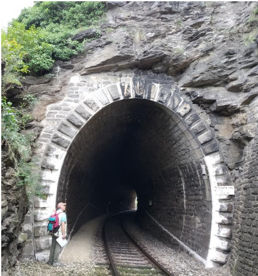
Abbildung 130 Innenschale des St.Michael Eisenbahntunnels (Ansicht Ostportal).
