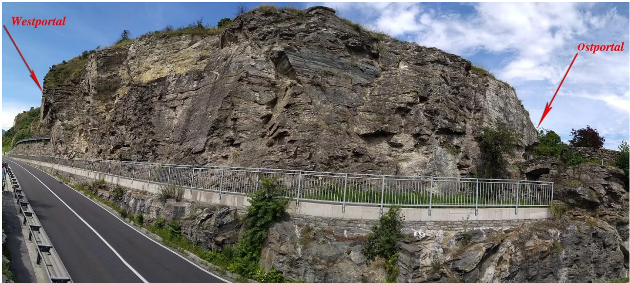
Abbildung 20: Ansicht der Böschung neben dem Tunnel. Das Ostportal ist im Bild rechts und das Westportal liegt links.
