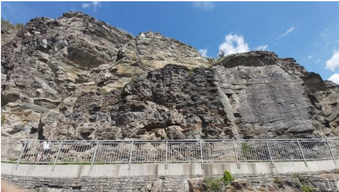
Abbildung 133b Standort der möglichen Keilbewegungen in den Portalböschungen des St.Michael Tunnels.
