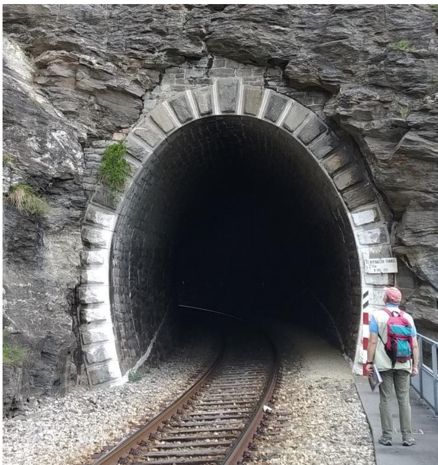
Abbildung 131 Innenschale des St.Michael Eisenbahntunnels. (Ansicht Westportal).
