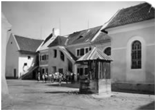
Synagoge Lackenbach, vor 1935.
