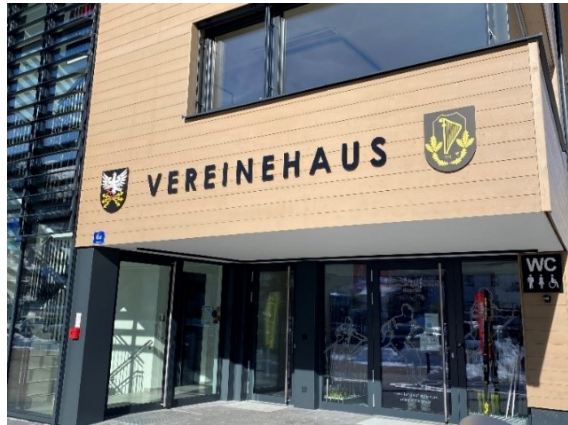
Abbildung 1: Verfugung als Stilmittel. Bewusste Verfugung mit -e- um eine Plural-Lesart zu provozieren. Im abgebildeten Gebäude in Kufstein sind mehrere Vereine untergebracht.
