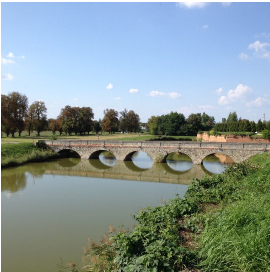
Abb. 236 Eine der zwei Brücken über den Wassergraben, heutiger Zustand
