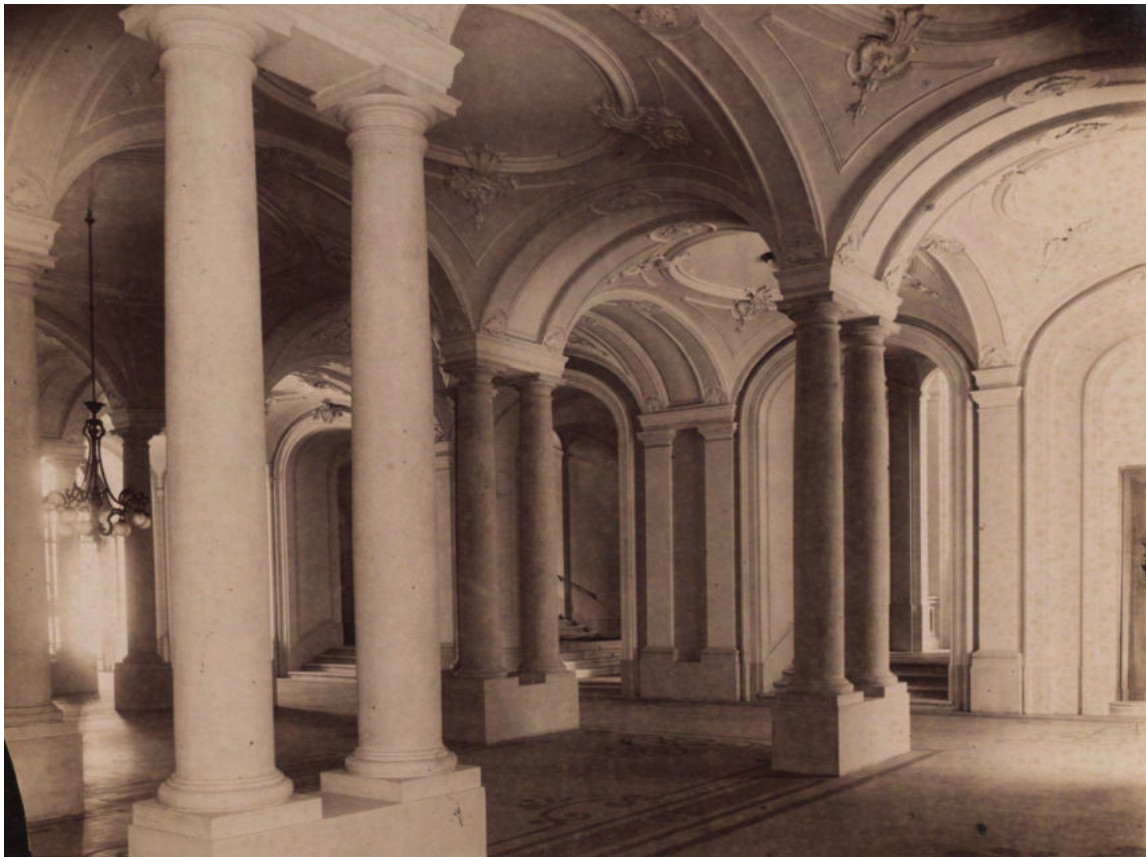
Abb. 285 Böhmische Kappengewölbe im Vestibul der Alten Universität
