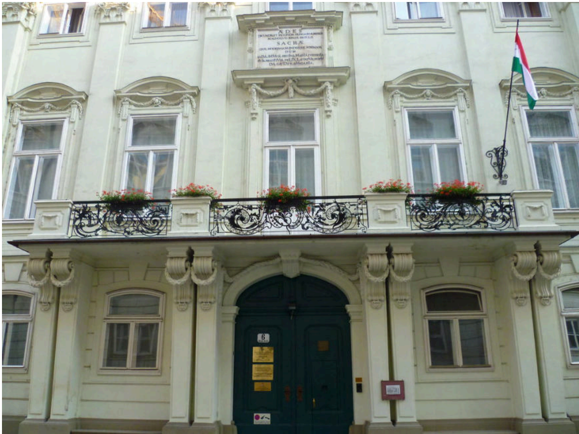
Abb. 333 Portal mit Balkon der Ungarischen Hofkanzlei
