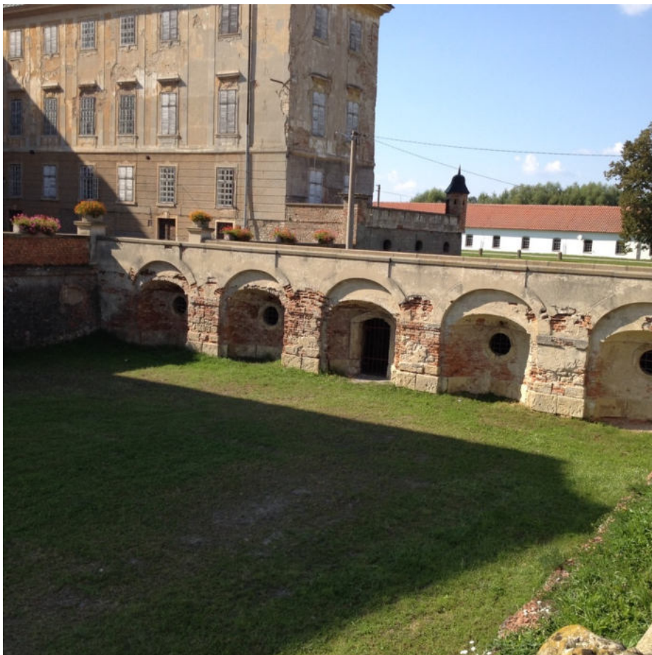
Abb. 240 Innengraben mit Brücke, heutiger Zustand
