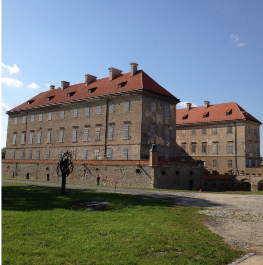
Abb. 255 Außenfassade der Schlossflügel, heutiger Zustand
