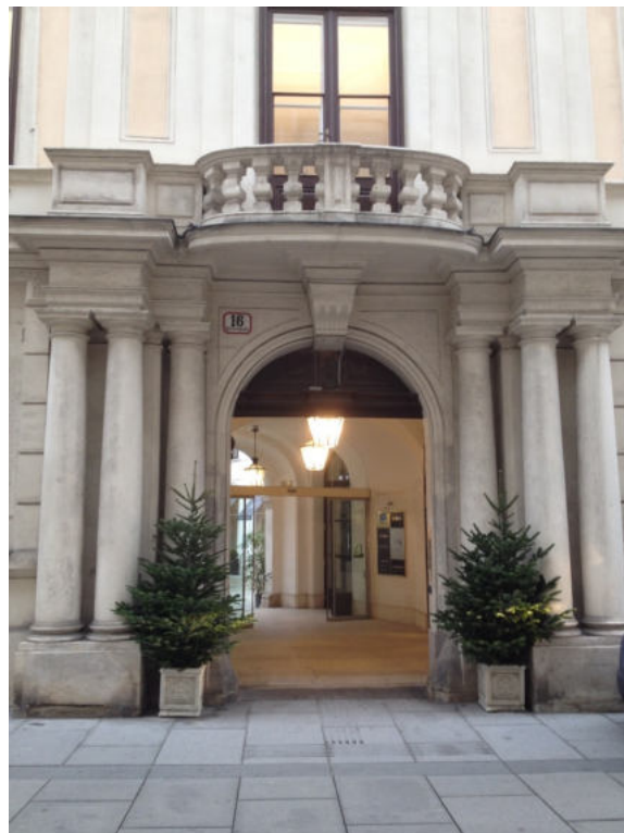
Abb. 37 Portal der Frontfassade (Herrengasse)
