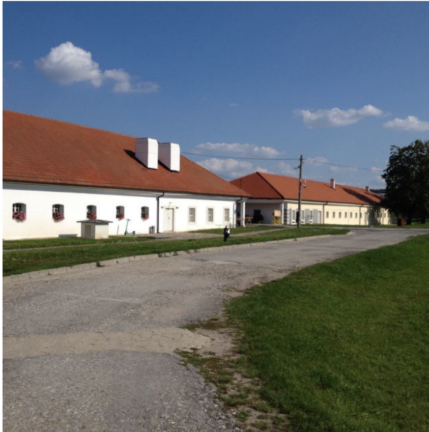
Abb. 237 Arsenalgebäude, heutiger Zustand
