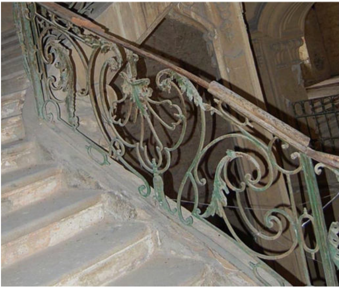
Abb. 290 Schmiedeiserne Treppengitter im Stiegenhaus
