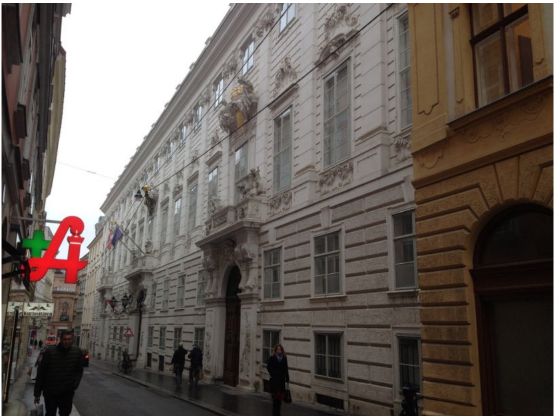
Abb. 109 Heutige Ansicht der Fassade
