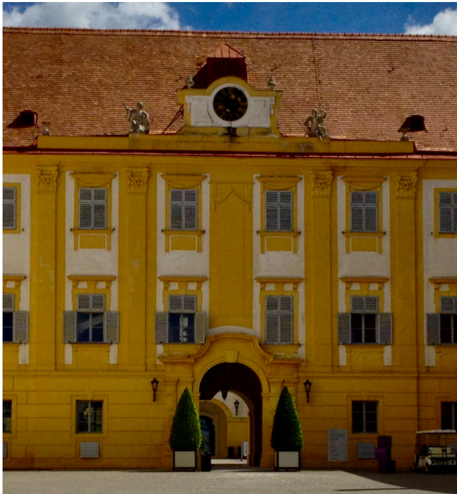
Abb. 340 Frontfassade des Corps de Logis, Franz Anton Hillebrandt, 1773-1775
