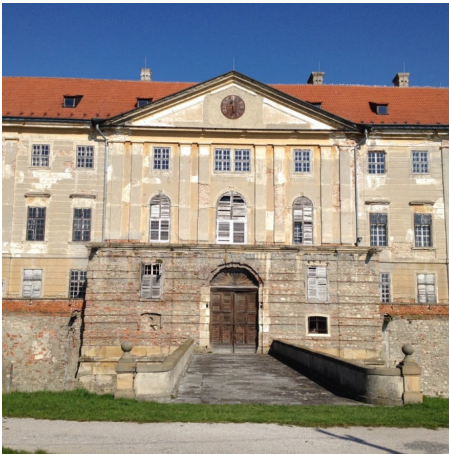
Abb. 252 Gartenfassade, heutiger Zustand
