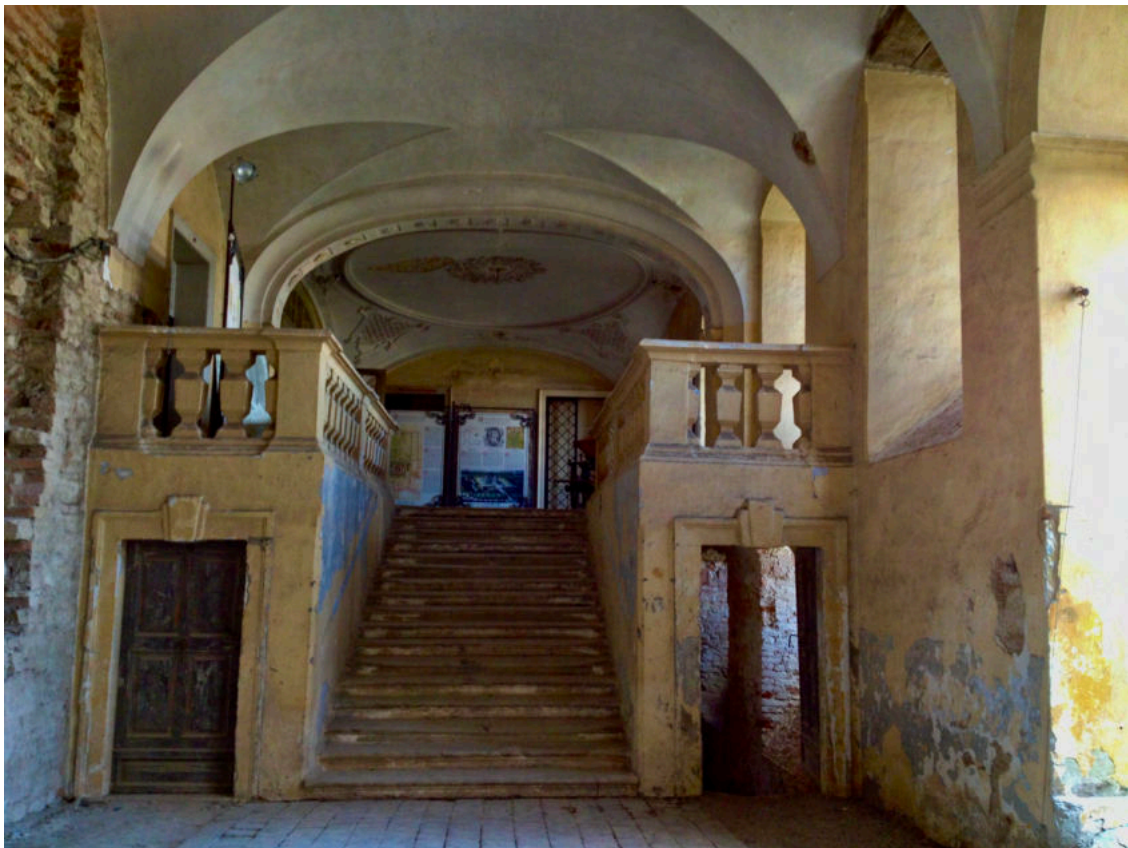
Abb. 282 Stiegenhalle mit Tribüne im Vestibul, heutiger Zustand
