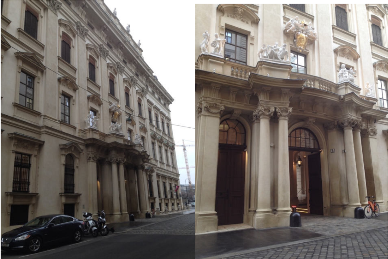
Abb. 103 und 104 Frontfassade und Portal des Stadtpalais Kaunitz-Liechtenstein, Domenico Martinelli, 1692-1705
