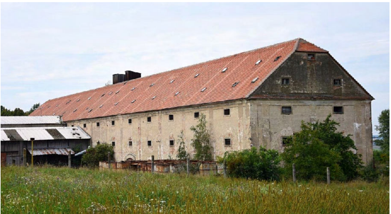
Abb. 224 Speicher in Holitsch, aktueller Zustand, 1757
