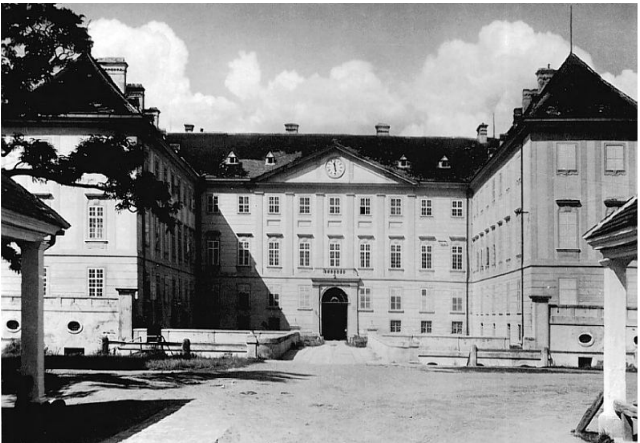
Abb. 246 Schloss nach der Fassadensanierung, um 1900
