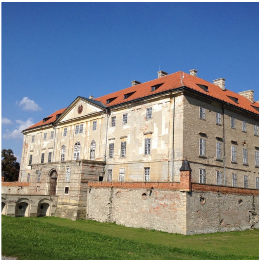
Abb. 256 Gartenfassade, heutiger Zustand
