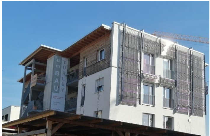
Abbildung 22: Solarthermie an der Hausfassade von umBAU 2 (Quelle: eigene Aufnahme)
