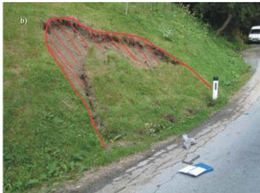
Abbildung 4: a) Rotationsrutschung und b) Translationsrutschung (GBA o. J., S. 9)
