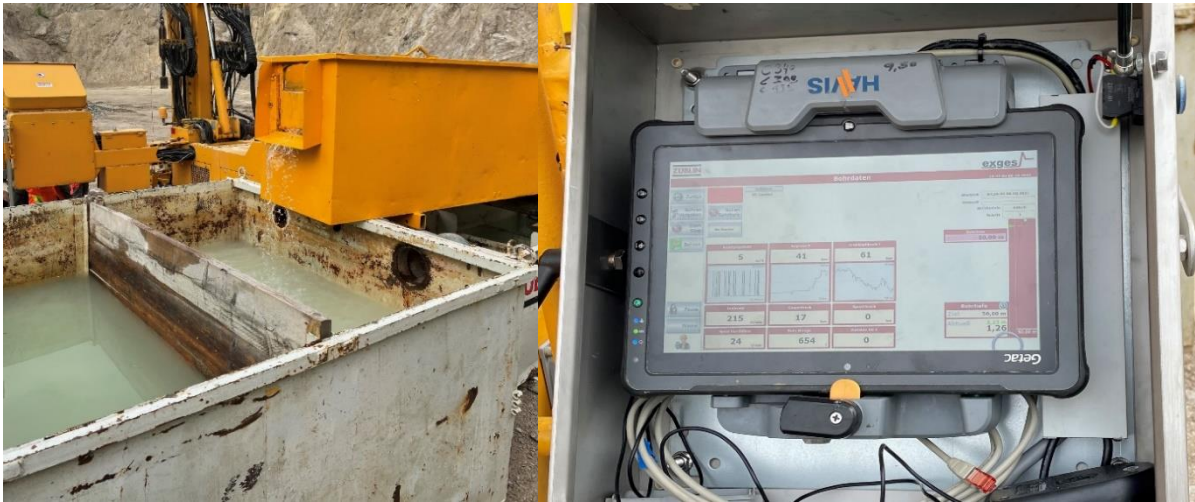
Abbildung 24: Absetzbecken der Bohrspülung (links) und Bohr-Computer (rechts).
