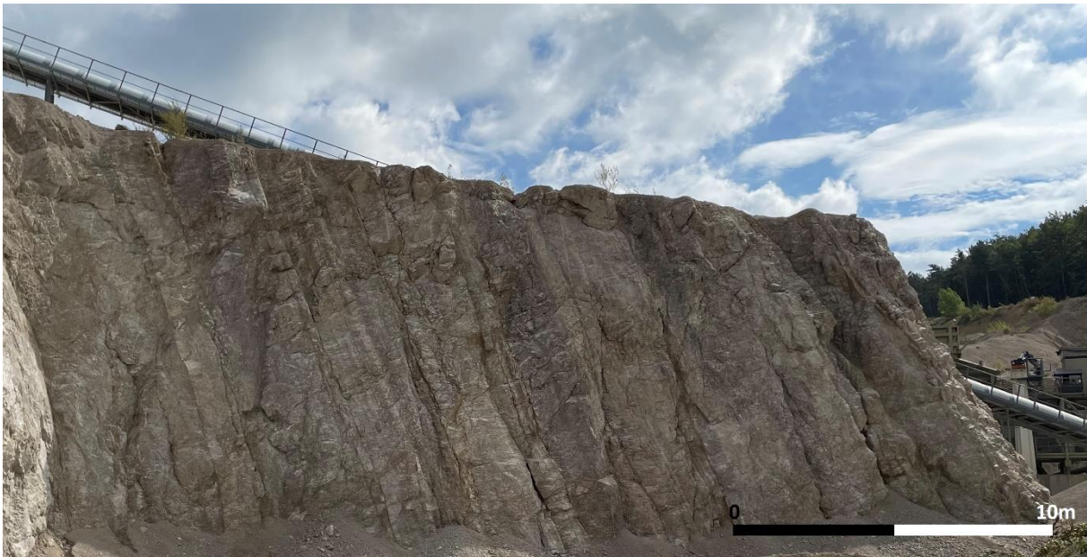
Abbildung 51: Steil nach Süden einfallende Schichtflächen im Bereich des Bohrplatzes (Profil A, Blickrichtung Osten).
