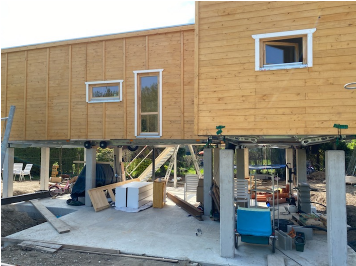
Abbildung 13: Unterbau eines Tiny Houses in Kleingartensiedlung. 451
