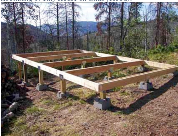
Abbildung 7: Unterbau eines THOS. 61
