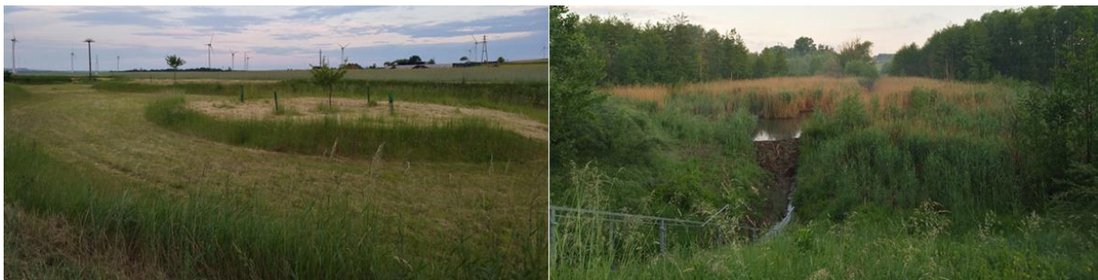
Abb. 1: Zwei Hochwasserrückhaltebecken (HRB) mit unterschiedlichen Habitatstrukturen, aufgenommen im Frühjahr 2022. Links: K2 in Altlichtenwarth, rechts: G8 zwischen Pellendorf und Gaweinstal.
