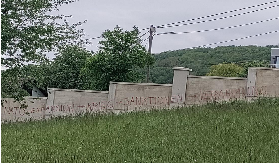
Abbildung 46: Steinhof-Mauer in 1140 Wien (Aufnahme von Anna Groß am 15.05.2023)
