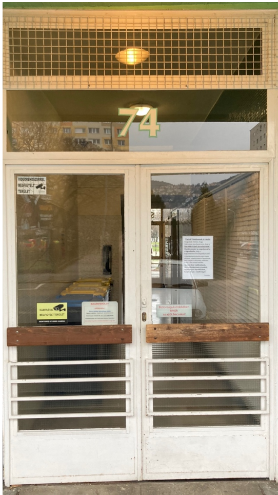
Abb. 70: Eingangstür eines Stiegenhauses im Faluház .
