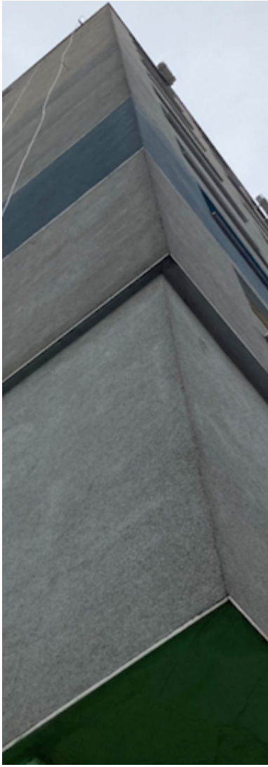
Abb. 46: Leichter Vorsprung der Wohngeschosse bei dem Faluház .
