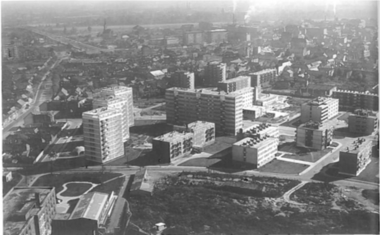
Abb. 9: Experimentelle Wohnsiedlung, II. Bauungsphase , Bebauungsplan: Albert Kiss/János Pomsár. Die Bauten der Mustersiedlung sind noch von den alten Bebauungsstrukturen umgeben, Budapest 1965.
