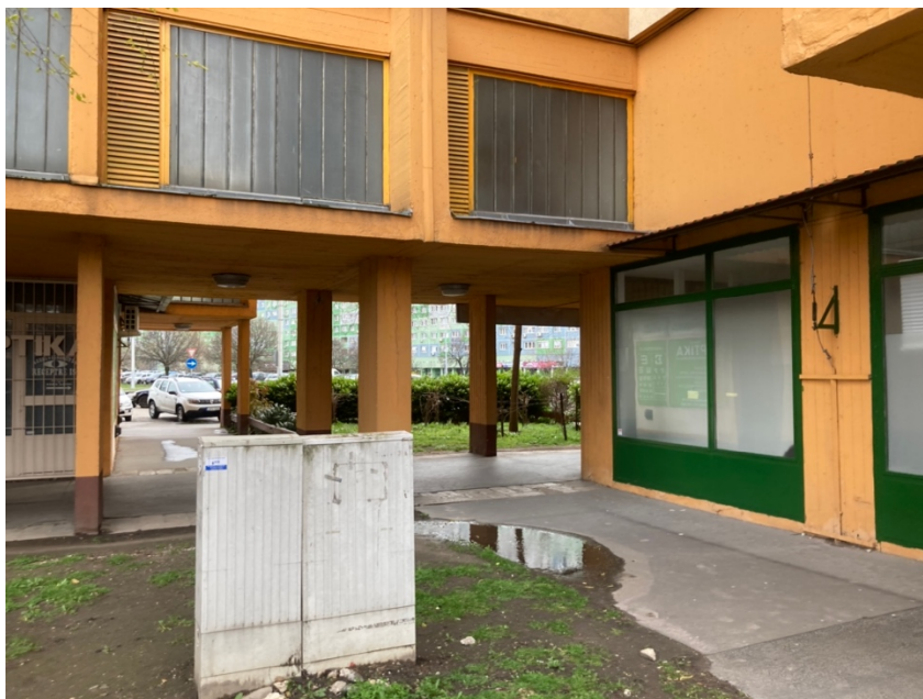
Abb. 55: Fügungstelle der Sektionen bei dem Haus mit Ohren Haus Nr. 10. im Erdgeschoßbereich.
