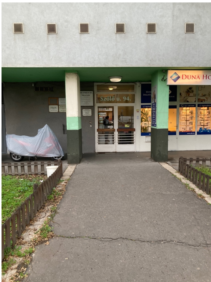
Abb. 69: Eingangstür eines Stiegenhauses im Faluház .
