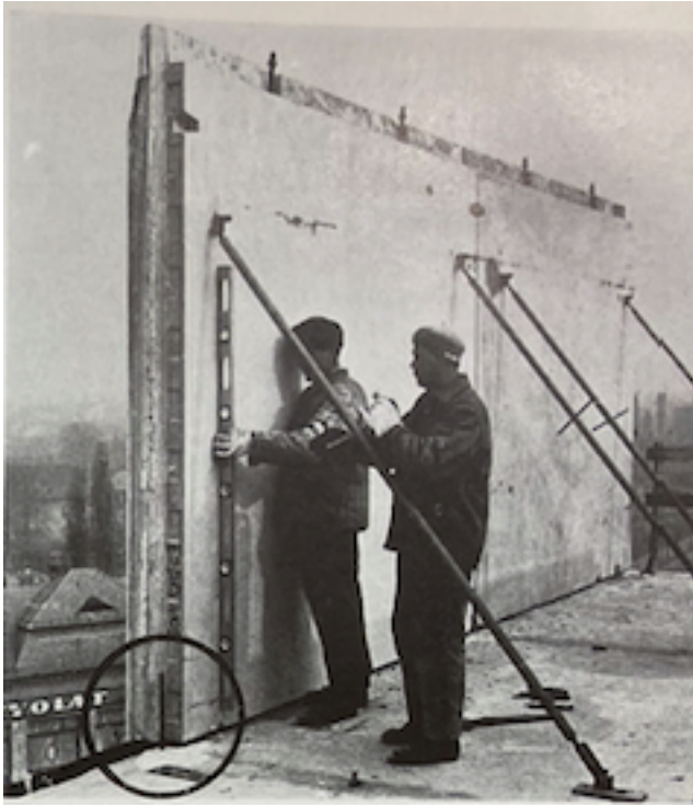
Abb. 38: Das „Ausstecken“ einer Fassadenplatte.
