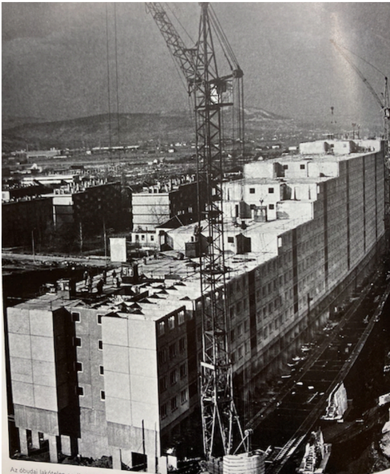
Abb. 39: Baustelle der Szentendrei -Straße entlang (wahrscheinlich Gebäude Nr. 39) um 1970.
