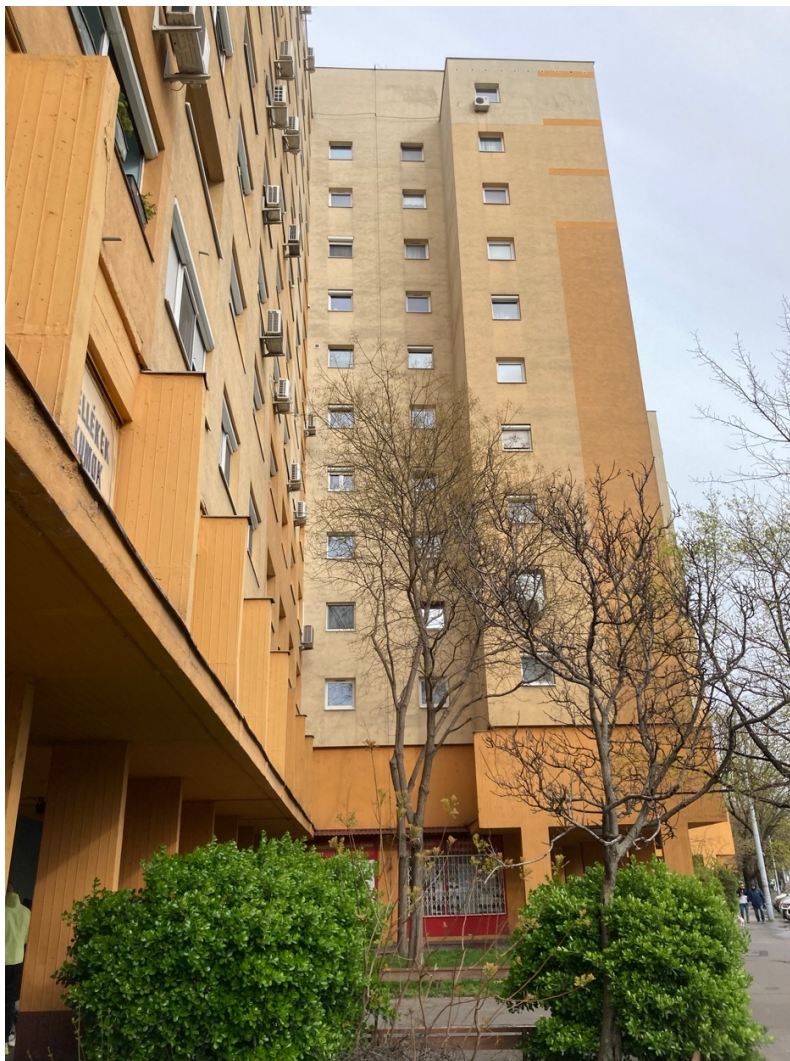
Abb. 57: Ein Dachaufbau des Haus Nr. 10. über den 10 Wohngeschossen.
