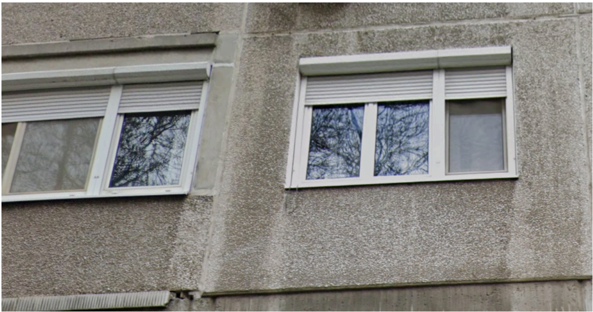
Abb. 67: Eine Verbesserung der Fugungstelle mehrerer Bauplatten (rechts oben) und die Reparaturen bei der Einsetzung einer Loggienverglasung (links oben).
