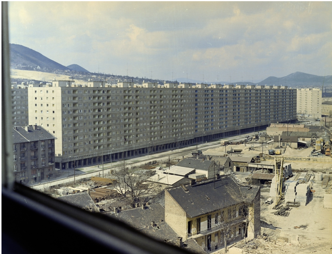
Abb. 48: Die ursprüngliche Fassadengestaltung des Faluház , welche von den vertikalen Linien der Loggien geprägt ist. (LAKÓTERV 1970) auf einer Fotografie aus 1974.
