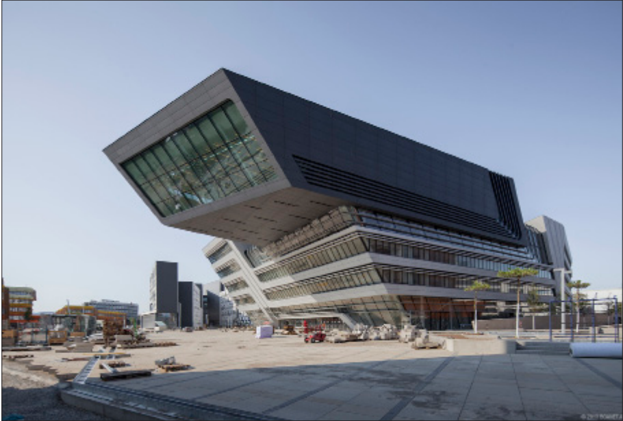
Abb.1: Library and Learning Center der WU Wien, Außenansicht (© BOAnet)
