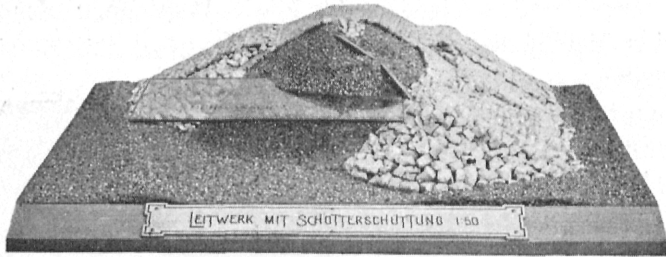
Modell eines Leitwerkes mit Schotterschüttung.
